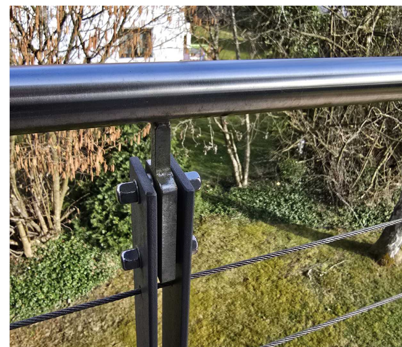
Beispiel Handlaufbestigung auf Pfosten mit Flacheisen
